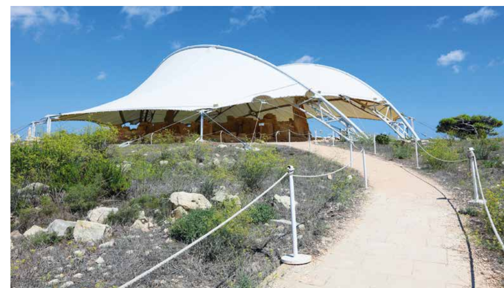
Hagar Qim. Na záchranu megalitických staveb získala Malta finance od EU, mnohé stavby se dočkaly zastřešení, které je chrání před nepřízní počasí
