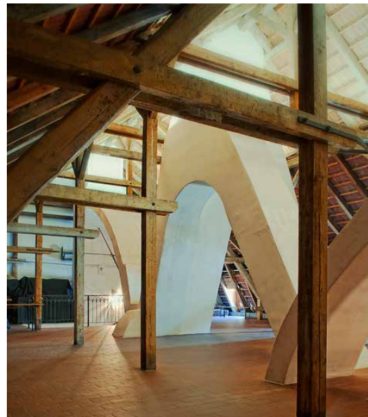
Zrestaurované půdní prostory s unikátním barokním komínovým systémem
